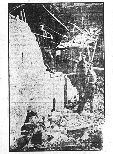
Wakutek eksplozji rezerwuaru gazoliny, dom, w którym się znajdował wyciekł w powietrze, przyczem 145 samochodów uległo zniszczeniu
