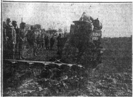
Traktor z wytwórni Stowarzyszenia Mechaników Polskich z 6-letnim skibowym pługiem o 11-morgowym placu w Pruszkowie, należący do Stowarzyszenia Mechaników Polskich.
