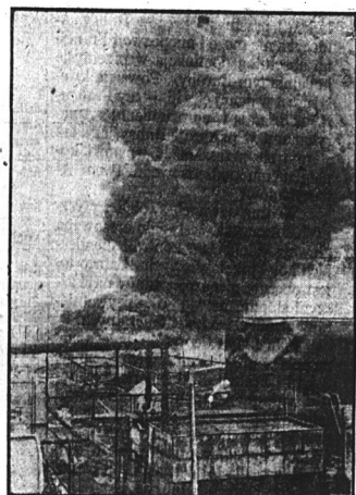
Pozar zbiornikow ropy w New Orleans spowodowany przez piorun wyrzadzil szkode na 1,000,000 dolarow
